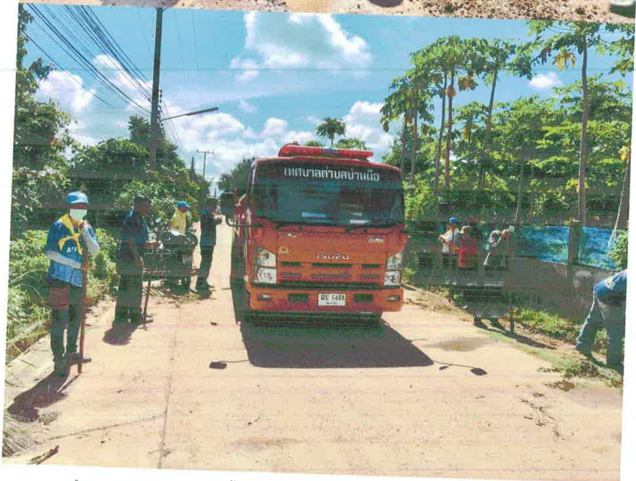
ทำความสะอาดร่องระบายน้ำ ใ้ถนนโขนทอง หมู่ที่ 1 ประจําปีงบประมาณ 2563
