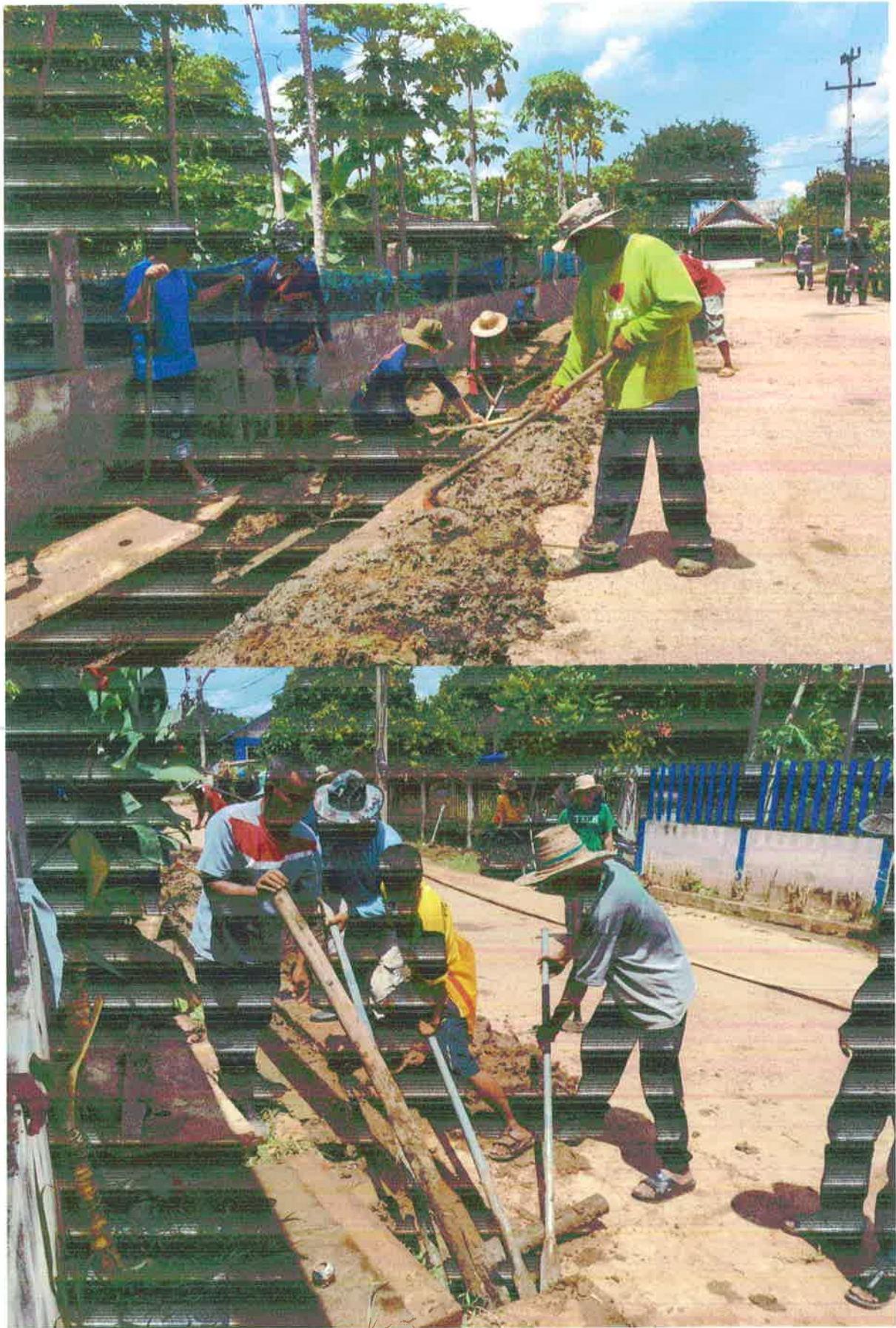
ทำความสะอาดร่องระบายน้ำ บ้านโนนทอง หมู่ที่ 1 ประจำปีงบประมาณ 2563
